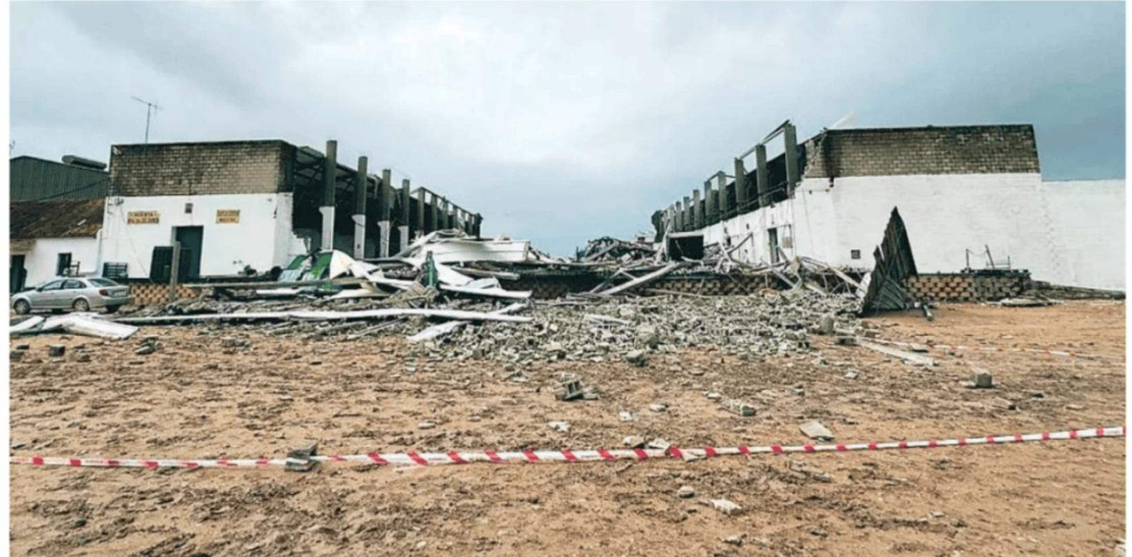
El viento derribó el techo y los muros de la nave
